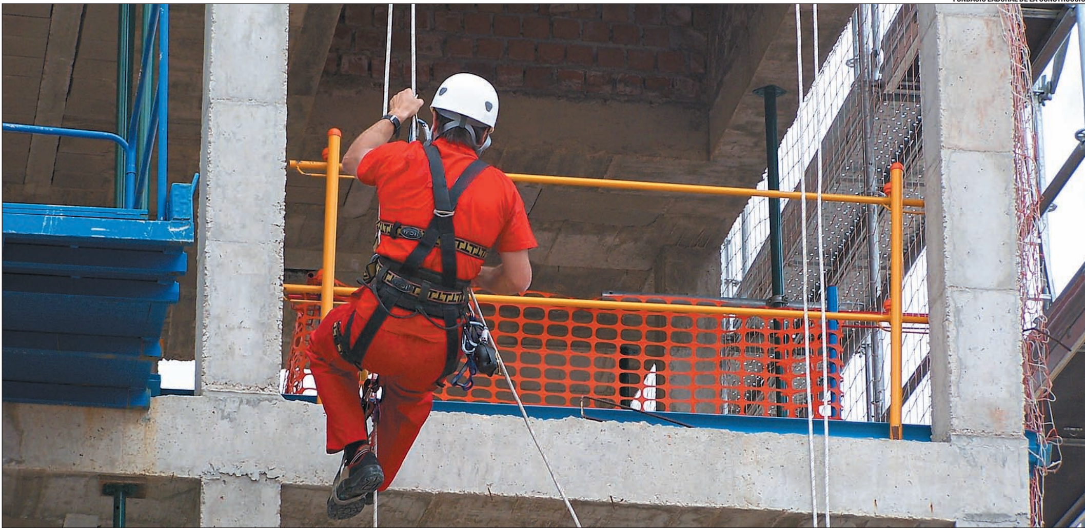
Un operari utilitza sistemes de seguretat mentre treballa en la construcció d'un edifici de vivendes.
