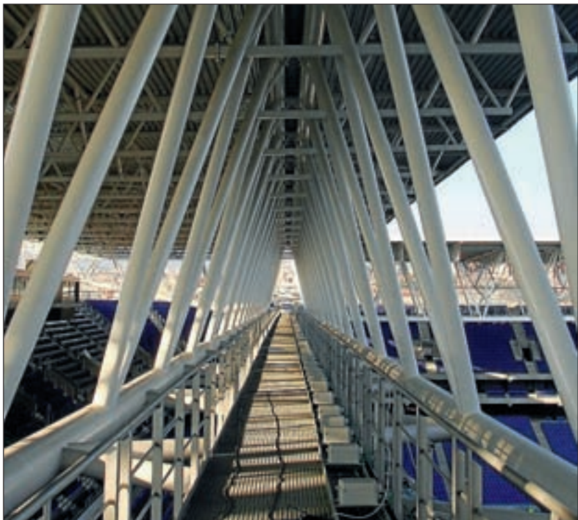
Passarel·la suspesa sobre el camp.
