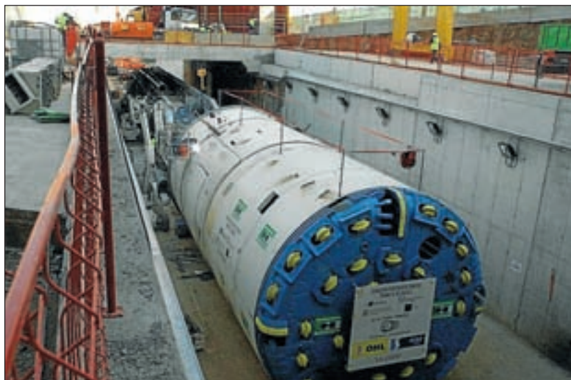
Una de les dues tuneladores que treballen en la interconnexió Fontsanta-Trinitat.
