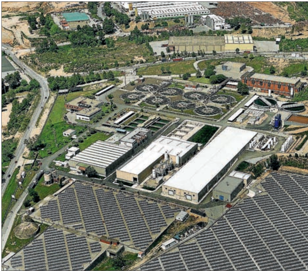
Vista aérea de la planta potabilizadora de Abrera.
