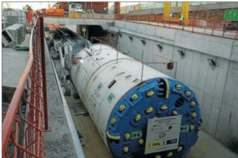
Una de las dos tuneladoras que trabajan en la interconexión Fontsa-Trinitat.
