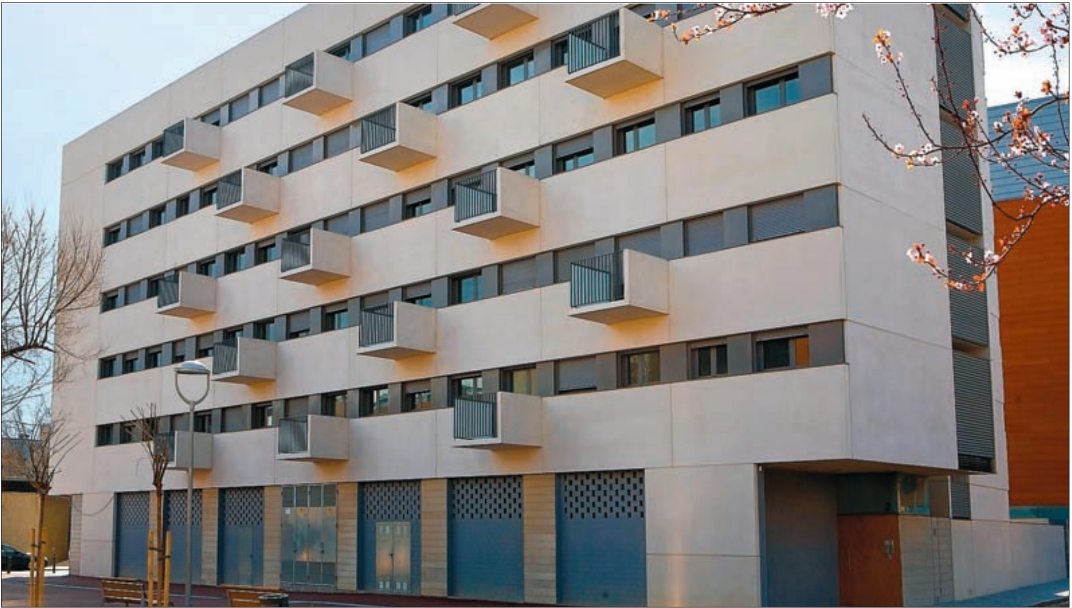
Vista exterior d'una promoció d'habitatges de protecció oficial situada a Santa Coloma de Gramenet.
