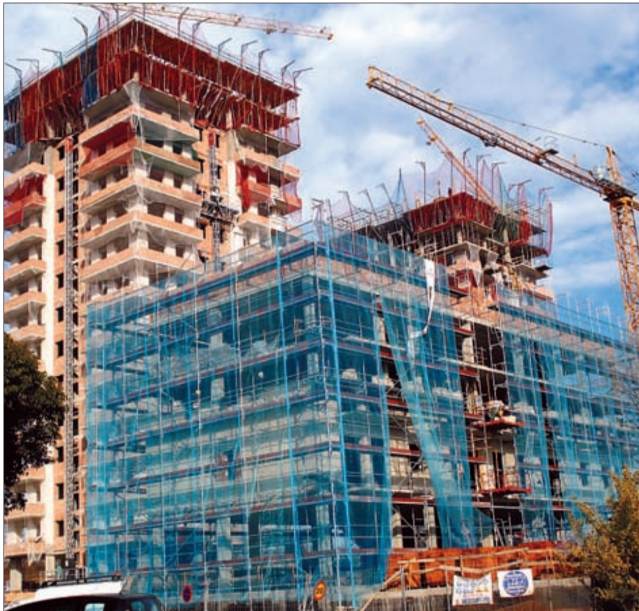
Edificios de viviendas en proceso de construcción.
