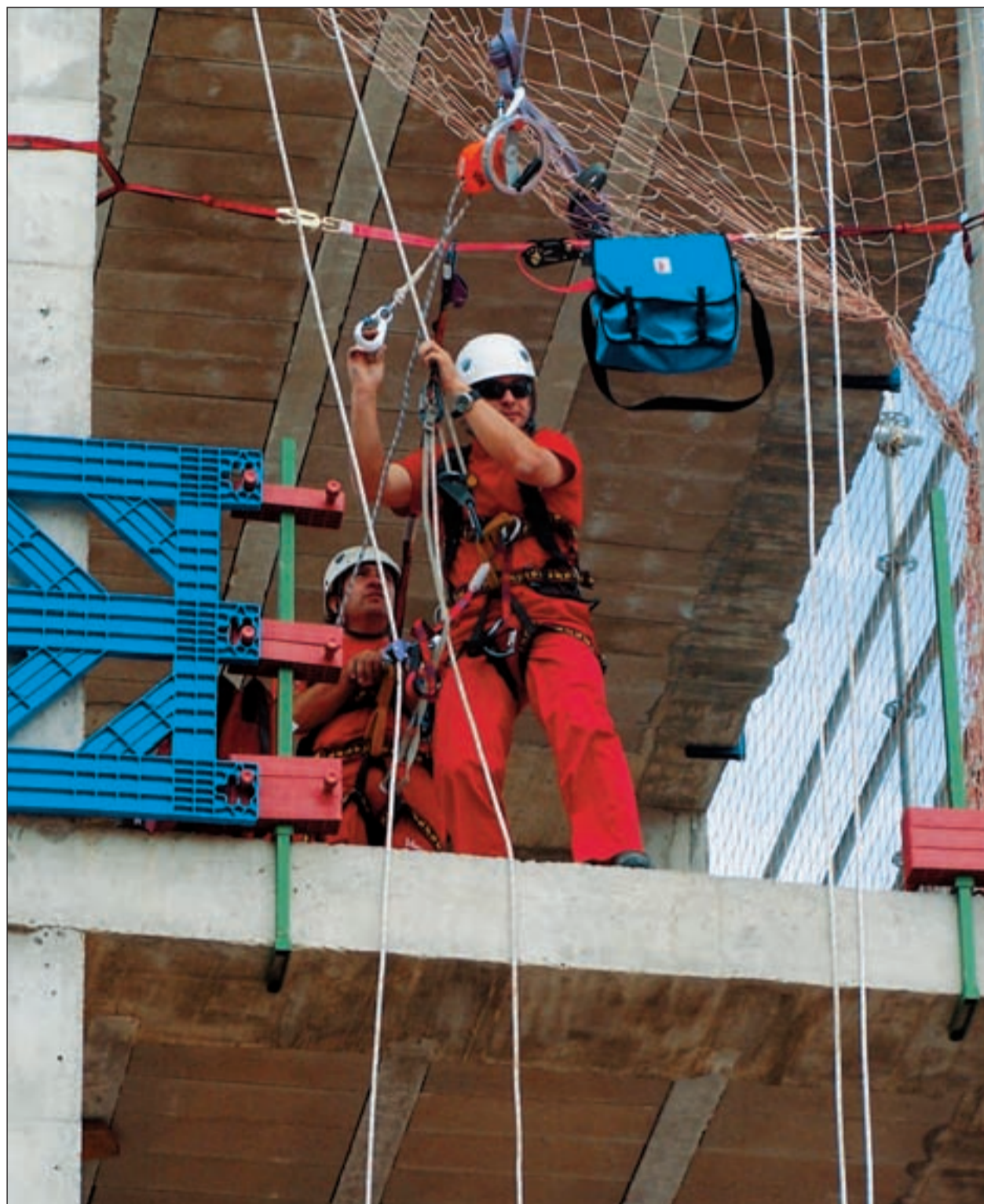
Dos trabajadores en una obra, con todos los elementos de seguridad necesarios, como cascos y arneses.
