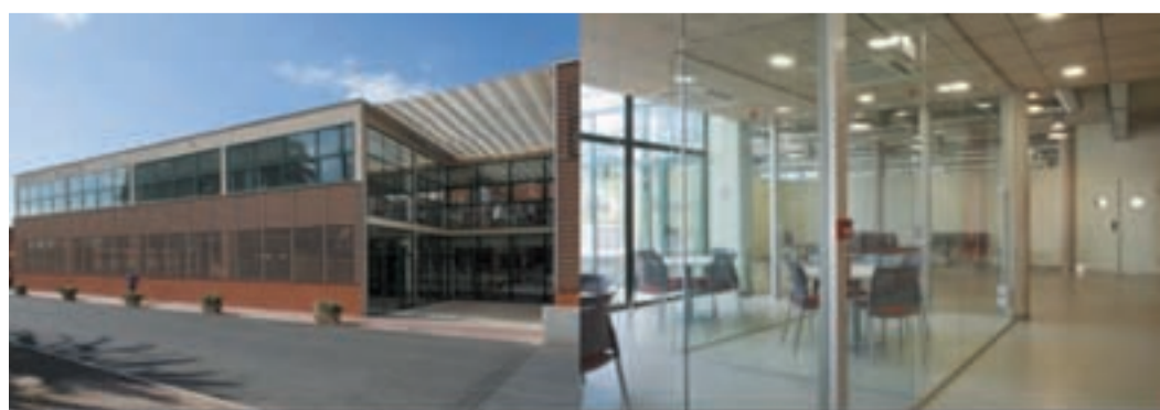
Construcció de l'edifici de Serveis Generals i Oficines de la Fundació Santa Teresa del Vendrell (Baix Penedès) Fotografies realitzades per Lourdes Jansana
