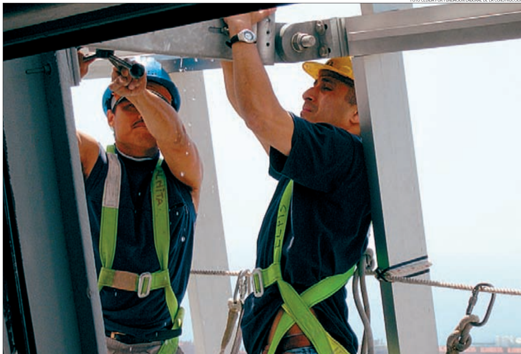
Dos obreros trabajan en la obra de un edificio convenientemente atados según la normativa laboral de la construcción.
