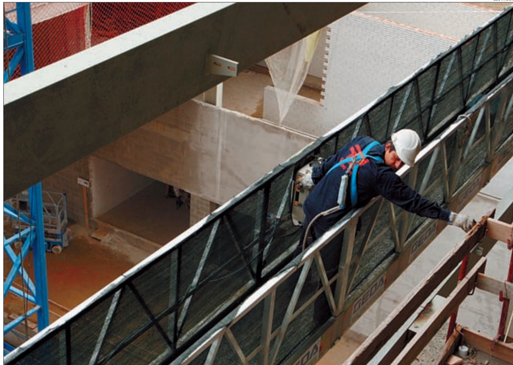
Un trabajador de la construcción interviene en una obra en Barcelona.
