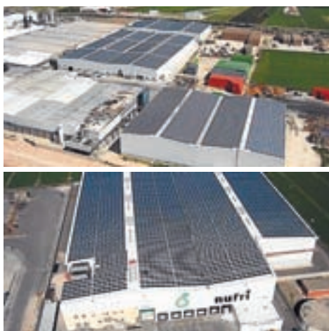
A dalt, el centre de Nufri a Mollerussa. A sota, les instal·lacions de Nufri a Vila-sana.
