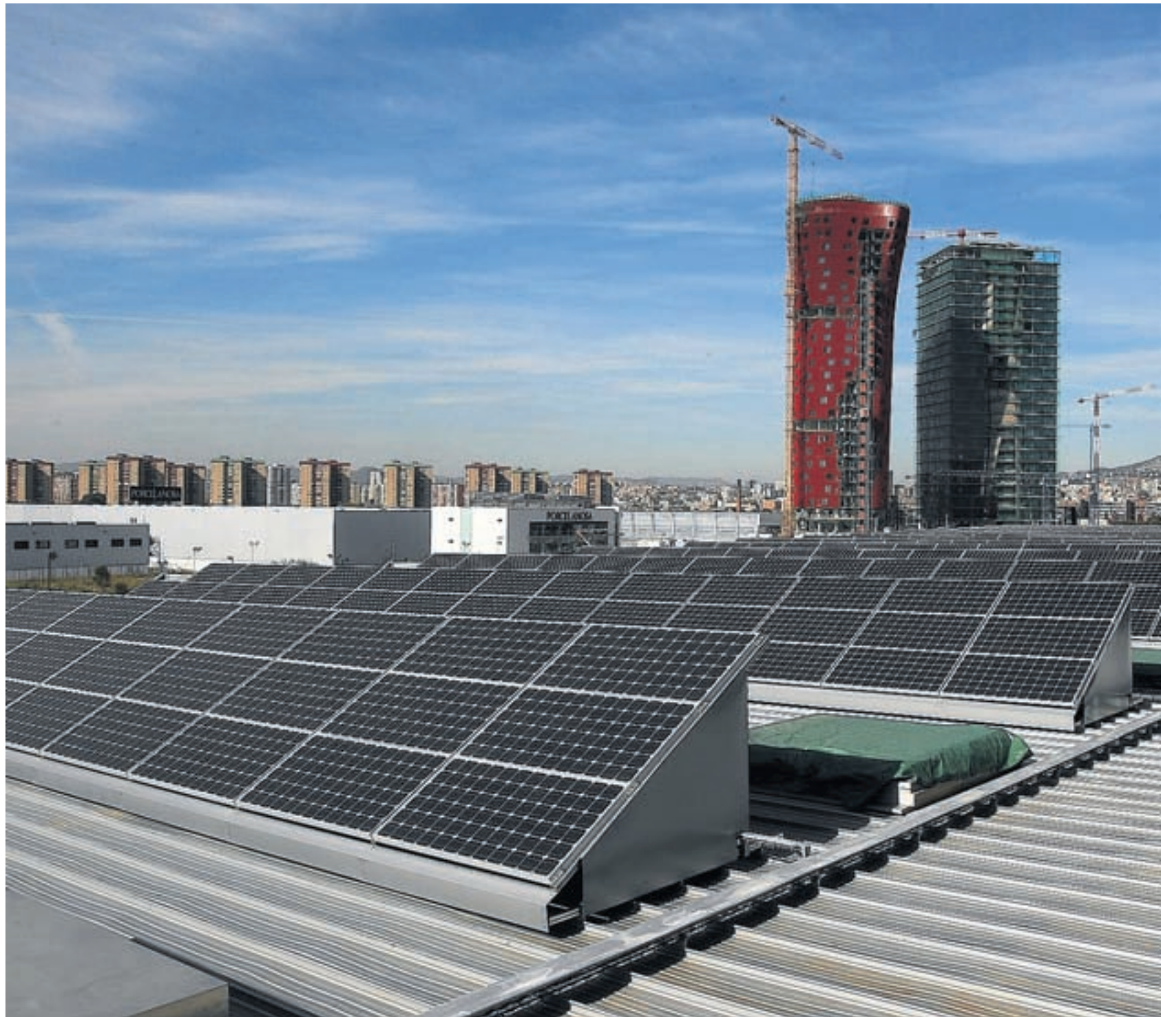
Plaques fotovoltaïques instal·lades a les cobertes del recinte firal de l'Hospitalet de Llobregat.
