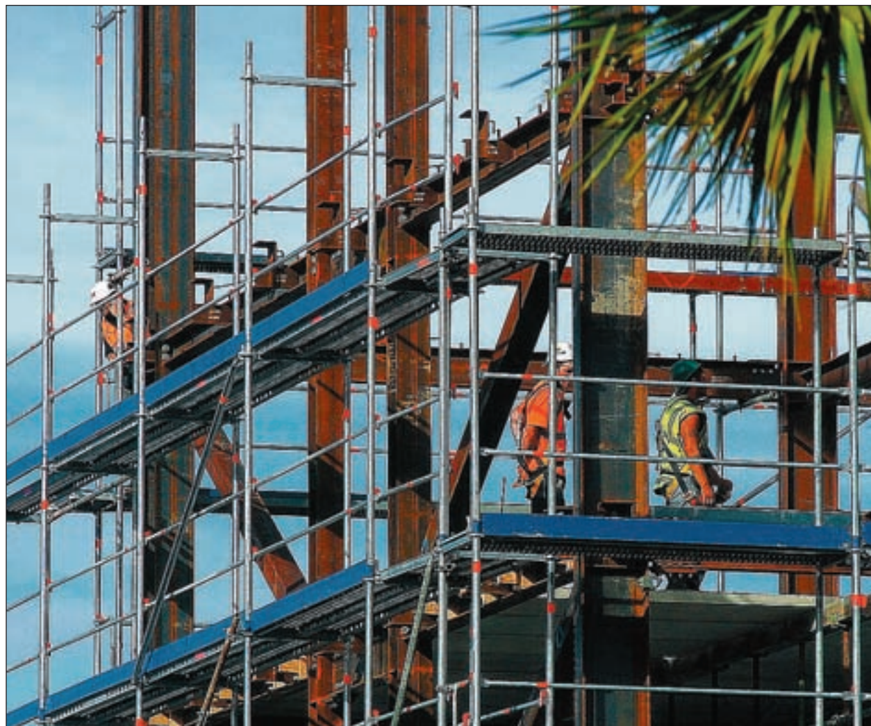
Operarios del sector de la construcción trabajan con sistemas de prevención de riesgos en una obra.
